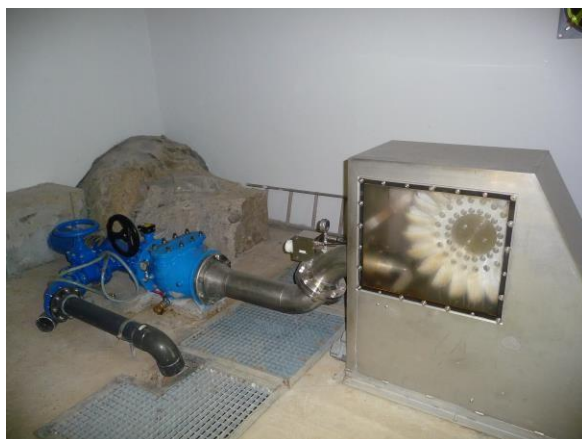
Figure 1 : La centrale hydroélectrique
